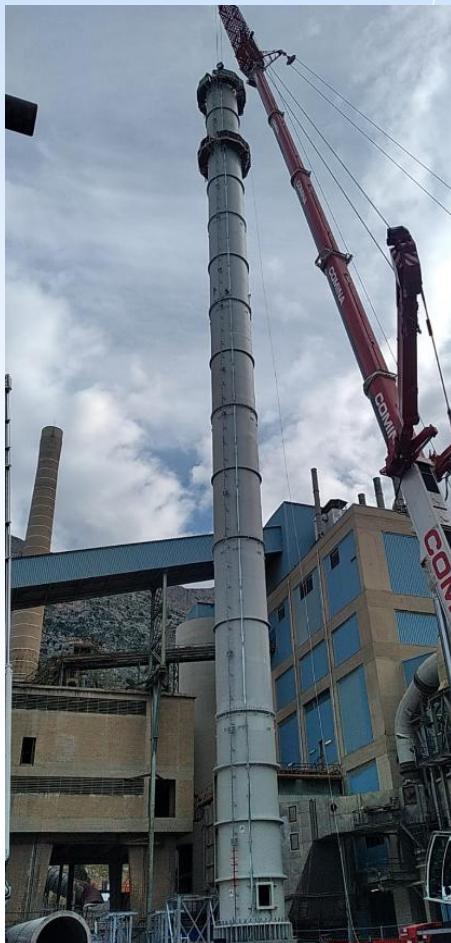
- Ciminiera – Fase finale e fase di montaggio
