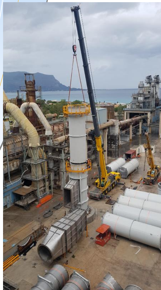
- Ciminiera – Fase finale e fase di montaggio
