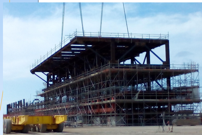
- Modulo in fase di montaggio
